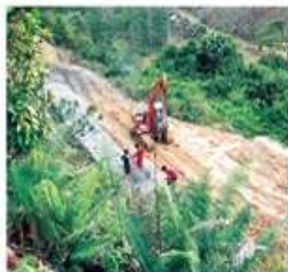
工事進行中の道路
